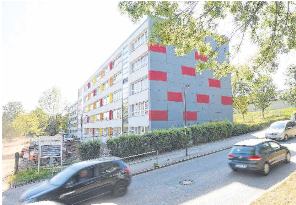
Zum Schulbeginn am 13. August 2018 wird das Oberschulgebäude an der Arno-Schreiter-Straße eingeweiht. Es wird seit Juli letzten Jahres saniert, um den Anforderungen als neuer Oberschulstandort zu entsprechen.
