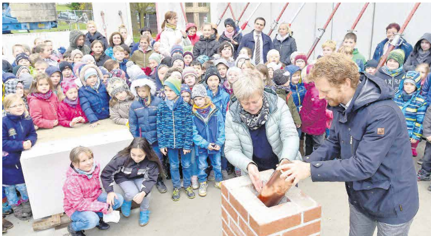
Am 10. November 2017 legten Schulleiterin Barbara Bergert und Baubürgermeister Michael Stötzer gemeinsam mit Schülerinnen und Schülern den Grundstein für den Erweiterungsbau der Grundschule Glösa. Mit Fertigstellung der Baumaßnahmen wird die Schule über Räume für acht Klassen verfügen und damit 2-zügig sein. Die Arbeiten am und im Schulhaus sollen bis zum Ende dieses Jahres abgeschlossen sein. Es entstehen unter anderem neue Fachräume für Informatik, Musik, Werken und Kunst.
