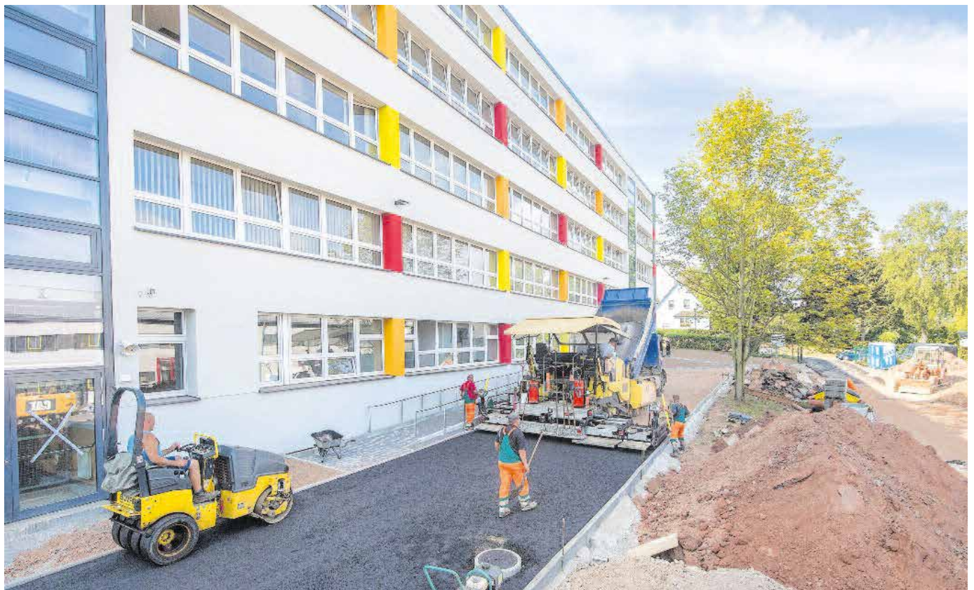
Letzte Arbeiten vor und in der Oberschule an der Arno-Schreiter-Straße 1 in Markersdorf. Das Schulgebäude wurde in den vergangenen Monaten modernisiert. Ab dem 13. August 2018 lernen hier – in der Außenstelle der Albert-Schweitzer-Schule – drei Klassen 5 mit jeweils 20 Schülern. Da weiter steigende Schülerzahlen prognostiziert sind, plant die Stadt zu einem späteren Zeitpunkt das Gebäude an der Arno-Schreiter-Straße 1 als eigenständige Oberschule zu betreiben.
