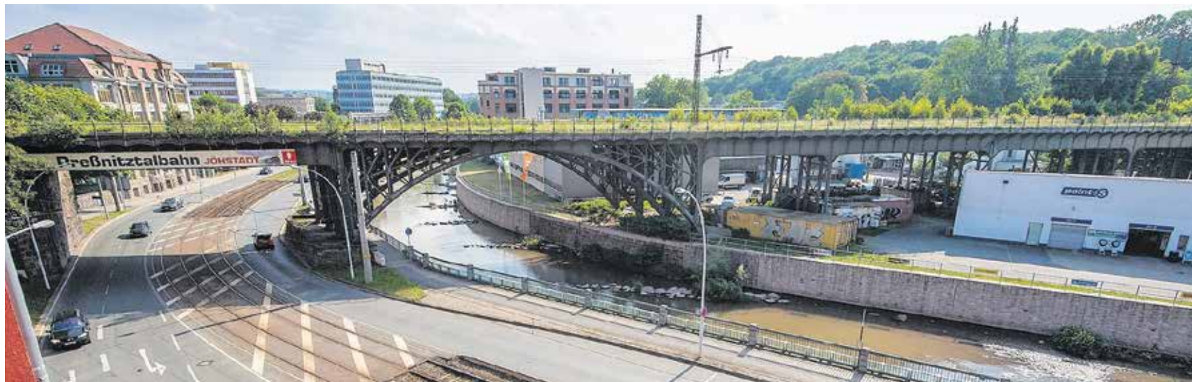
Für den Erhalt eines stadtbildprägenden Baudenkmals haben sich Chemnitzer stark gemacht: Das 1905 errichtete Viadukt an der Annaberger Straße steht seither unter besonderem Fokus der Öffentlichkeit – dies einmal mehr auch zum Denkmaltag. Foto: Kristin Schmidt
