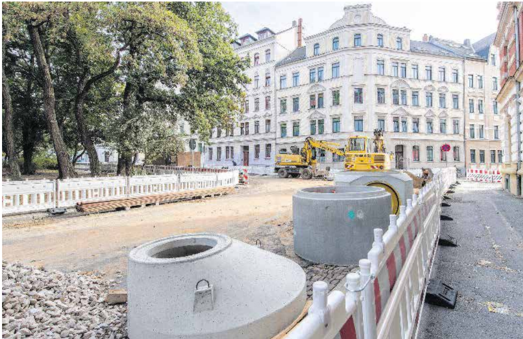
Mitte September 2018 haben Bauarbeiten zum grundhaften Ausbau des Lessingplatzes zwischen Lessingstraße und Sebastian-Bach-Straße begonnen. Foto: Kristin Schmidt
