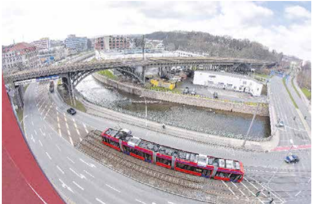
Zur dritten Sitzung des Fachbeirates Anfang Februar waren die Auswertung der Gutachten zur Bausubstanz des Viaduktes und mögliche Varianten zur Ertüchtigung der Brücke die Schwerpunktthemen. Foto: Kristin Schmidt
