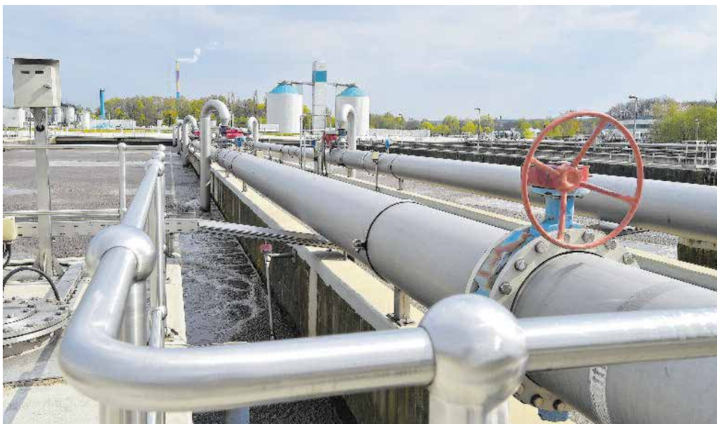
Zum Tag der Erneuerbaren Energien am 26. April 2019 öffnet in diesem Jahr die Zentrale Kläranlage von eins ihre Tore. Foto: Kristin Schmidt
