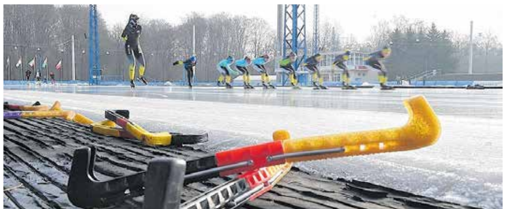
Die Eisschnelllaufbahn im Eissportzentrum wird saniert.
