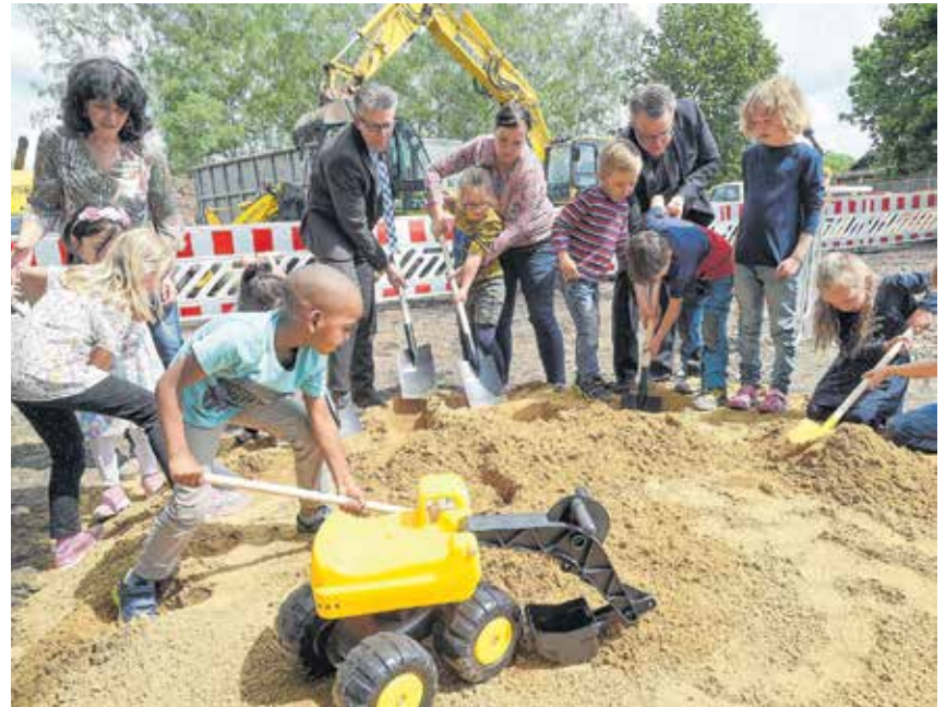
Kinder kamen auch auf das Kita-Baugelände in Altendorf, um Sozialbürgermeister Ralph Burghart beim offiziellen Spatenstich zu unterstützen. Foto: Andreas Seidel
