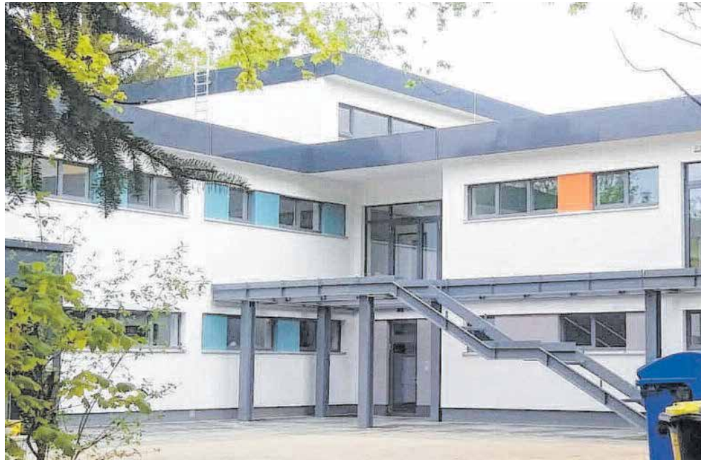
Seit der letzten Einwohnerversammlung für Gablenz und das Yorckgebiet wurde einiges gebaut: Beispielsweise hat die Stadt die Kindertageseinrichtung an der Liddy-Ebersberger-Straße 2 komplett saniert.
