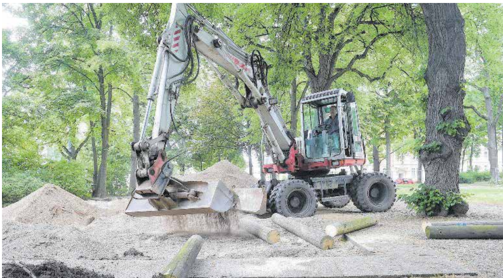
Mit dem Abriss der alten Spielgeräte hat die beauftragte Firma bereits begonnen. Für November 2019 ist die Fertigstellung des neuen Platzes geplant. Foto: Andreas Seidel
