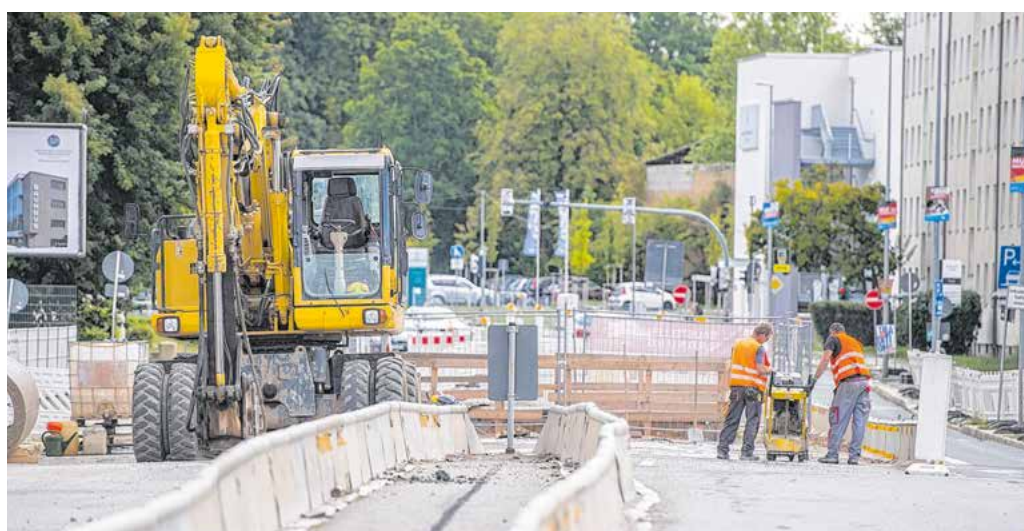
Für Kanalbauarbeiten und das Errichten einer neuen Brücke über die Bahngleise ist ab dem 26. August 2019 eine Vollsperrung der Zschopauer Straße erforderlich. Foto: Georg Ulrich Dostmann
