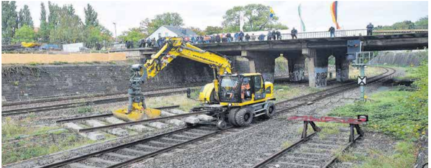
Am Freitagvormittag fand der offizielle Baustart für die Straßenbrücke Zschopauer Straße statt.
