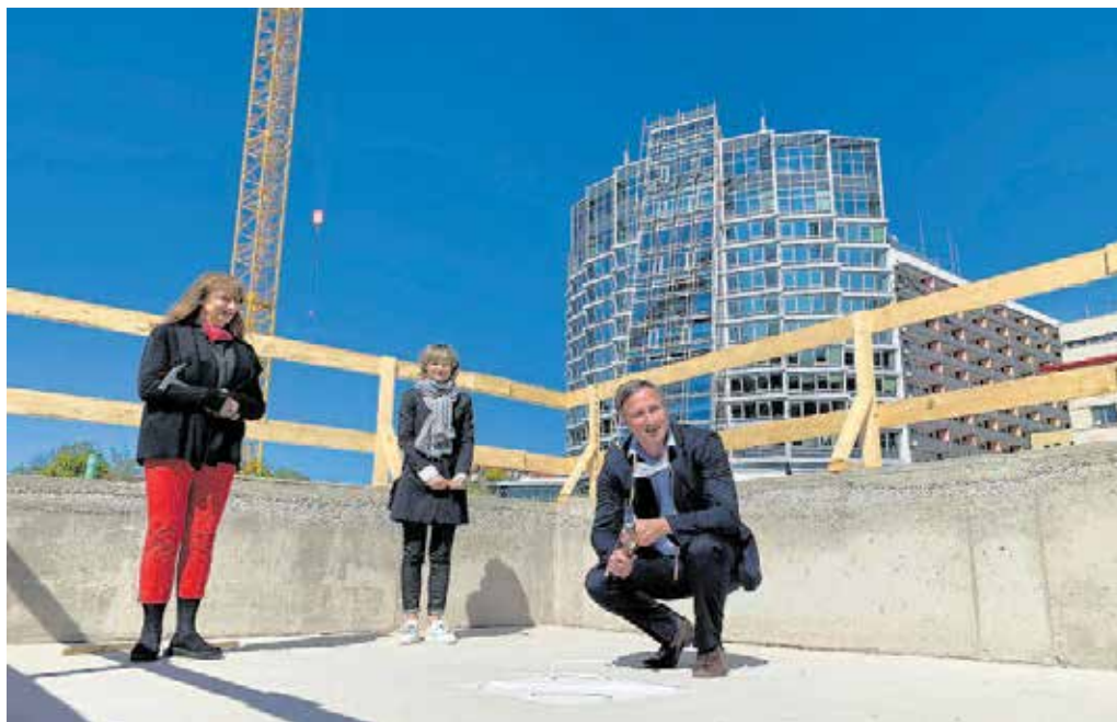
Staatsministerin Petra Köpping, Oberbürgermeisterin Barbara Ludwig und Geschäftsführer Dirk Balster (von links) bei der Grundsteinlegung für den Neubau von Haus 9 am Standort Flemingstraße 2 des Klinikums Chemnitz.
