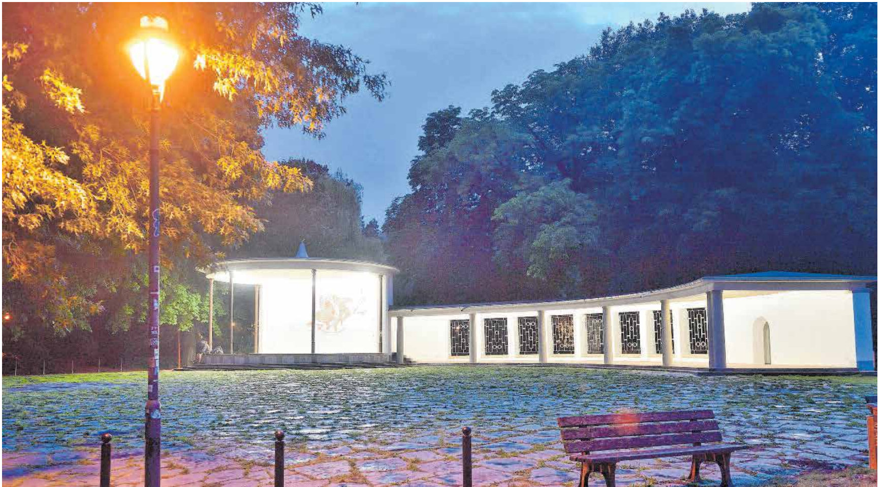
Der Schloßteichpavillon ist unter Berücksichtigung des Denkmalschutzes saniert worden. Eine Beleuchtung setzt ihn in den Abendstunden wirkungsvoll in Szene.
