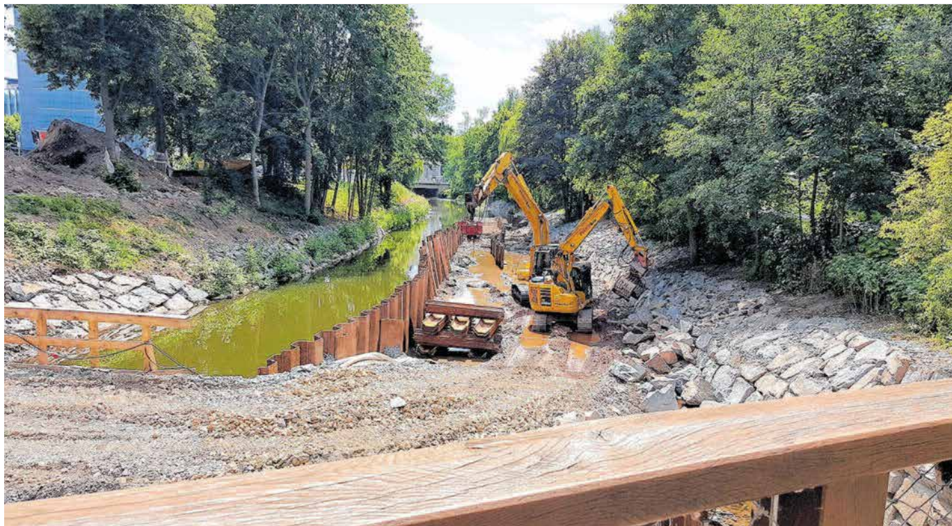
Am Pfortensteg laufen im Flußbett der Chemnitz Baumaßnahmen, die die Landestalsperrenverwaltung in Auftrag gegeben hat. Foto: Monika Ehrenberg
