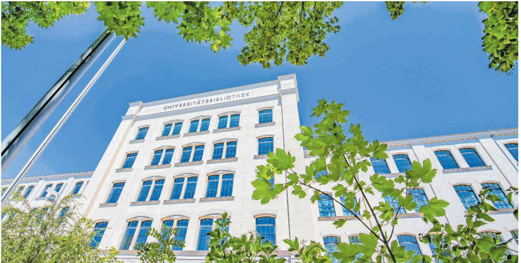
Das historische Gebäude der Alten Aktienspinnerei an der Straße der Nationen 33 ist der neue Standort der Universitätsbibliothek der TU Chemnitz. Die Kubatur und die Fassadengestaltung des historischen Komplexes wurden in ihrer ursprünglichen Form wieder hergestellt. Fotos: TU Chemnitz / Jacob Müller
