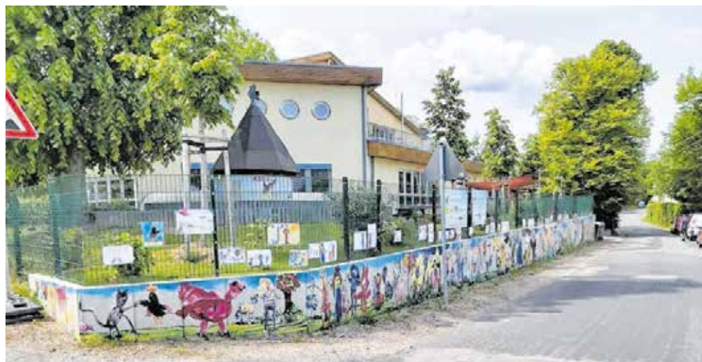
Aus den Mitteln des Bürgerbudgets wurde auch die Stützmauer der Kita Rabennest in der Kieselhausenstraße neu gestaltet. Vorlage dafür waren die Bilder der Kita-Kinder.
