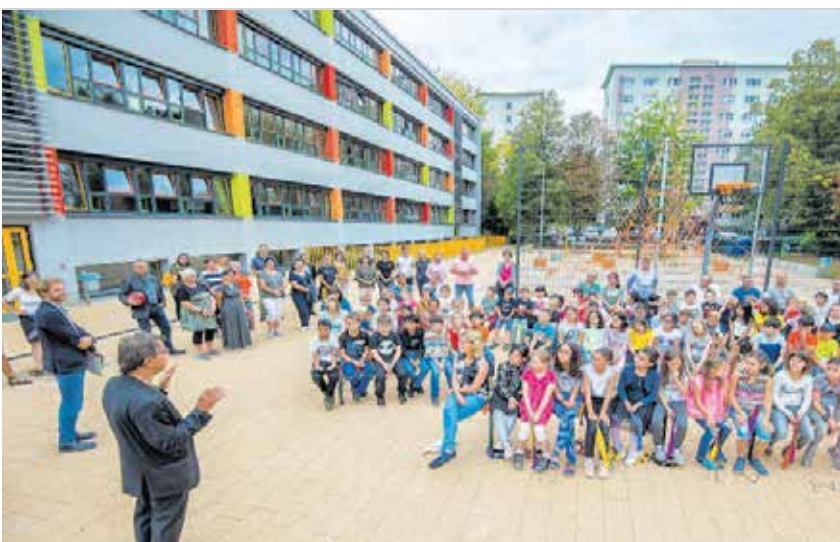
Im Beisein von Bürgermeister Michael Stötzer wurde die Heinrich-Heine-Schule nach der Sanierung wieder in Betrieb genommen. Unter anderem stehen neu gestaltete Außenanlagen für abwechslungsreiche Pausenaufenthalte zur Verfügung. Foto: Georg Dostmann
