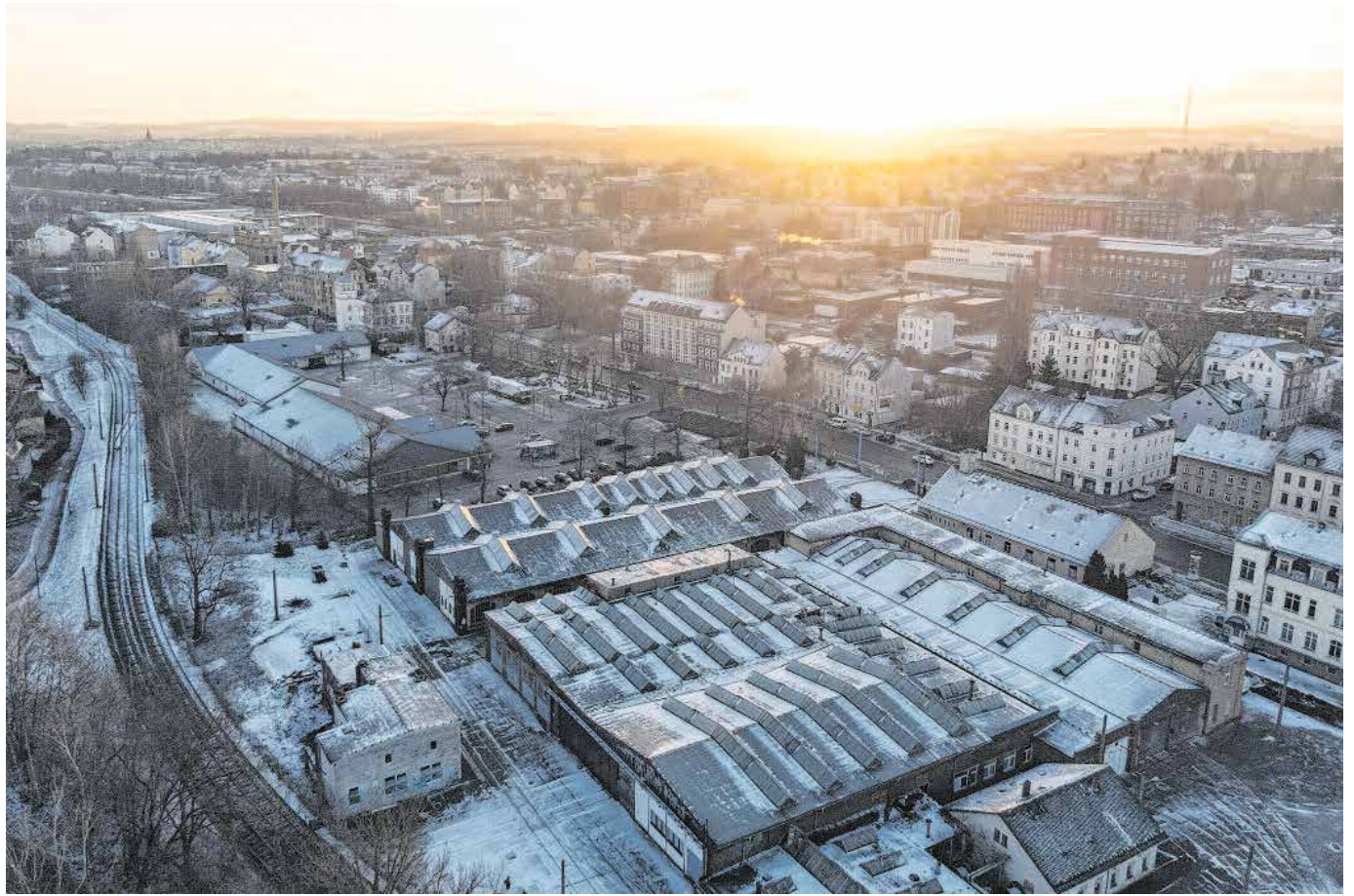
Auf dem Gelände im Stadtteil Kappel befinden sich heute unter anderem das Straßenbahn- und das Uhrenmuseum. Für das Kulturhauptstadtjahr 2025 ist auf der Interventionsfläche der sogenannte Garagen-Campus geplant. Foto: Ernesto Uhlmann
