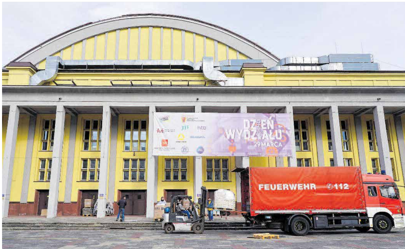
Die »Hala sportowa« in Lodz wird aktuell zum Lagern von Hilfsgütern aus verschiedenen Ländern genutzt. Dort werden die Spenden sortiert und neu verpackt, anschließend werden sie entweder an die Grenze gefahren oder an Geflüchtete in der Stadt verteilt. Foto: Philipp Köhler
