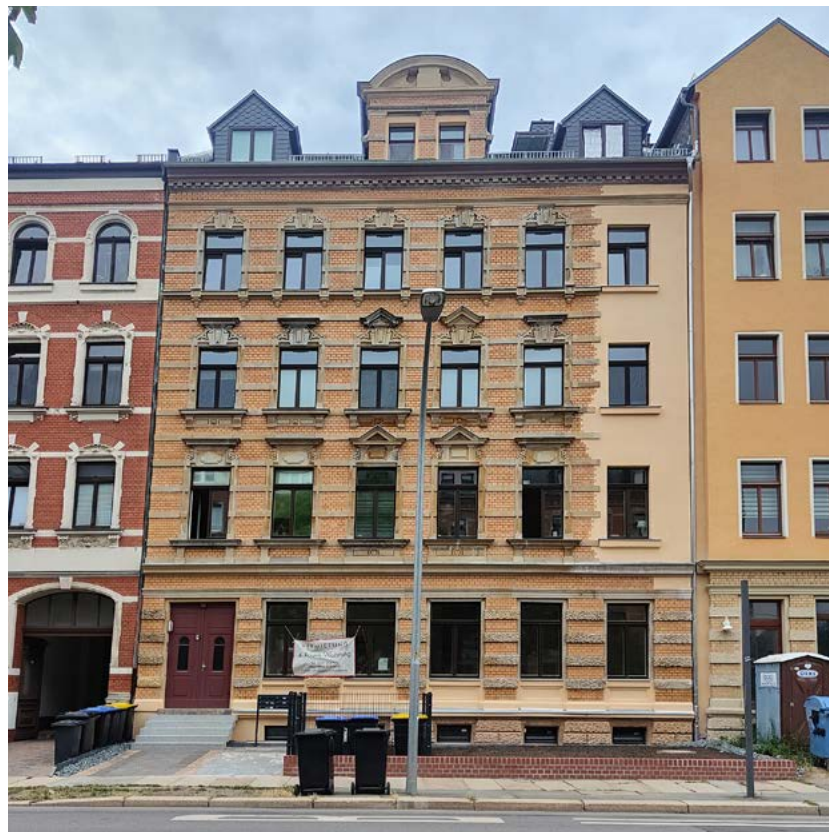
Nach der Sanierung erstrahlt die Fassade in hellen Farben.
