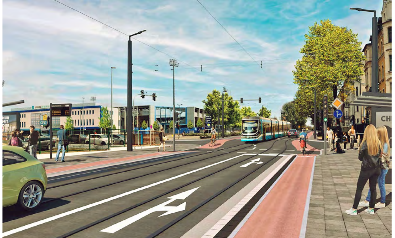
Entlang der Heinrich-Schütz-Straße entsteht eine neue Straßenbahnlinie.
