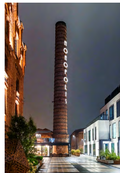
Der Schornstein der ehemaligen Wodkafabrik Monopolis. Heute finden sich dort Büros, Gastronomie und Freizeiteinrichtungen. Foto: Industriemuseum Chemnitz
