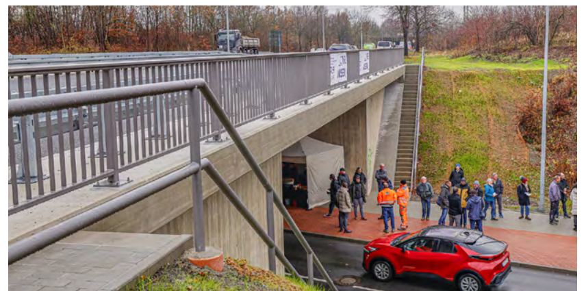
Die Brücke, die über die Straße Im Neefepark führt, wurde in insgesamt 15 Bauphasen abgetragen und neugebaut.
