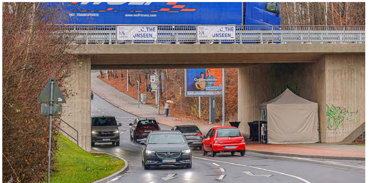
Nach umfangreichen Bauarbeiten ist die Neefestraße wieder freigegeben. Mit der Modernisierung wurden die Verkehrssicherheit verbessert und die Infrastruktur auf 1,2 Kilometern ertüchtigt. Fotos: Harry Härtel
