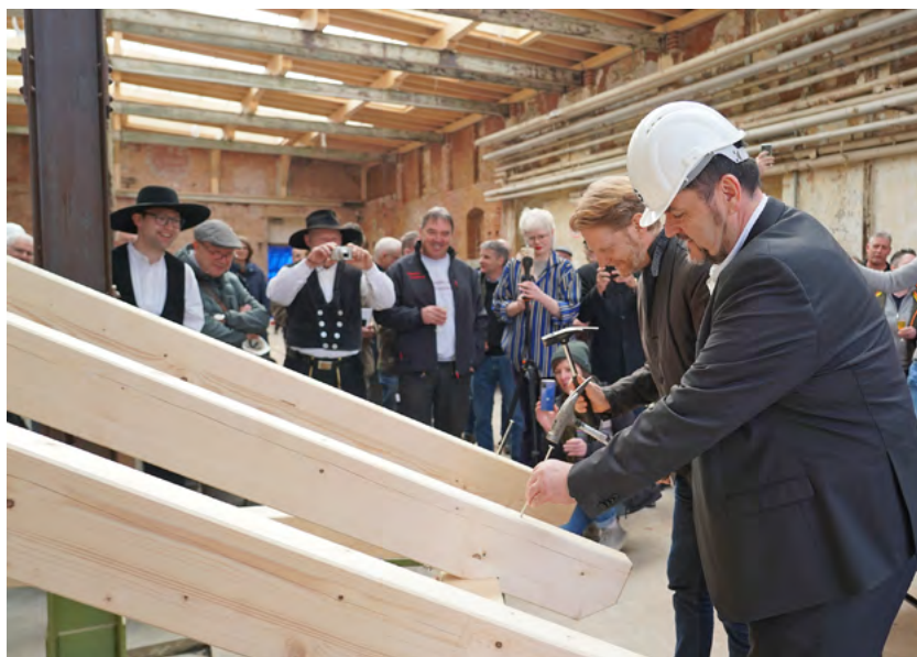
Der Garagen-Campus wird zum kulturellen Treffpunkt für Mobilität und Gemeinschaft. Mit dem Richtfest im März wurde ein weiterer Schritt auf dem Weg zur Kulturhauptstadt Europas Chemnitz 2025 gefeiert. Im Frühjahr 2025 soll er feierlich eingeweiht werden.
