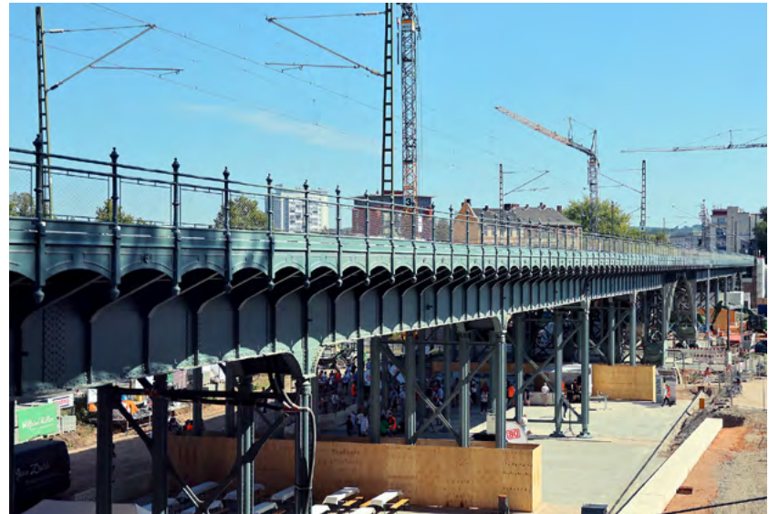
Der Chemnitzer Bahnbogen erstrahlt nach umfassender Modernisierung. Nach vier Jahren Bauzeit ist die Verbindung der Sachsen-Franken-Magistrale nun komplett barrierefrei und verkürzt die Reisezeit zwischen Hof und Dresden auf 2,5 Stunden. Foto: Peggy Schellenberger
