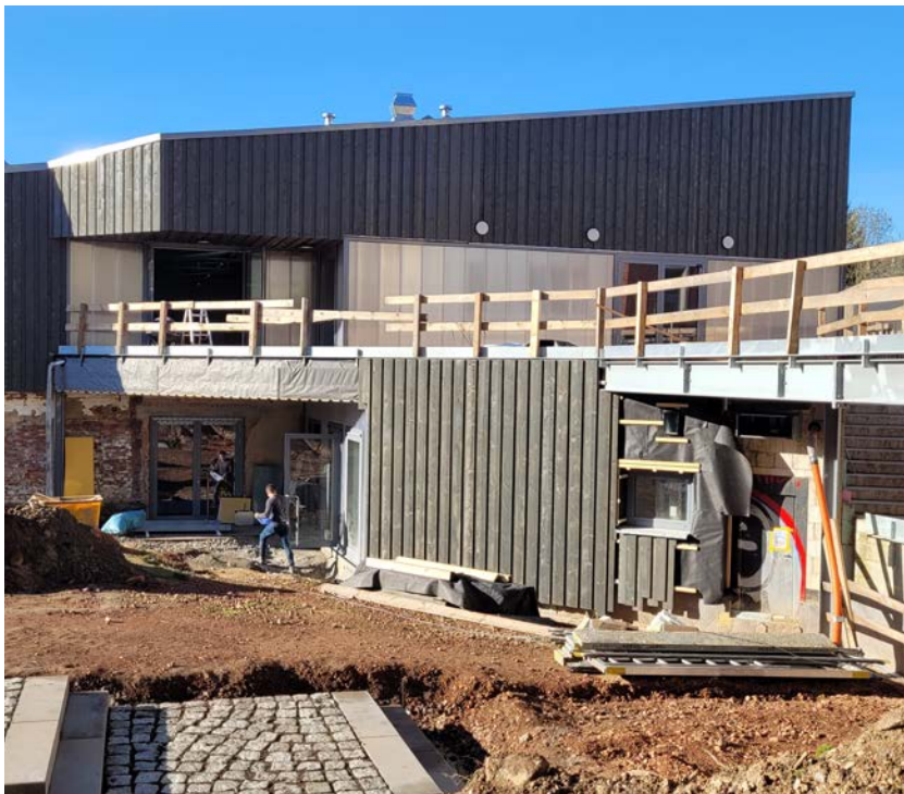
An der Interventionsfläche Stadtwirtschaft entstehen neue Gebäude.
