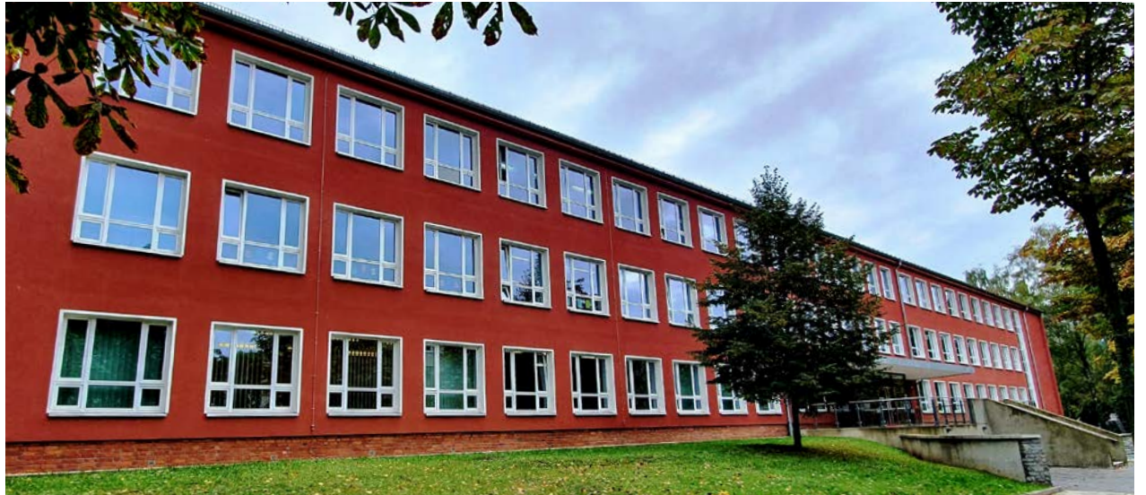
Die Gebrüder-Grimm-Grundschule auf dem Kaßberg wird saniert.
