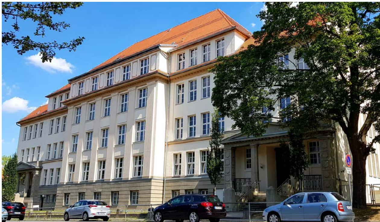
Die Schülerinnen und Schüler der Annenschule – Grundschule werden ab dem neuen Schuljahr in mobilen Klassenräumen auf dem Gelände der Jan-Amos-Comenius-Grundschule unterrichtet. Foto: Schulamt/Stadt Chemnitz
