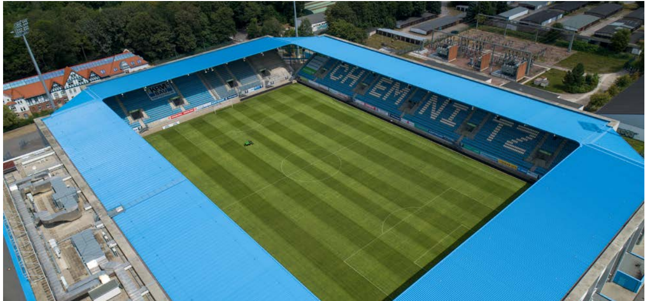
Auf dem Dach des eins-Stadions werden mehr als 1.600 Photovoltaik-Module installiert.
