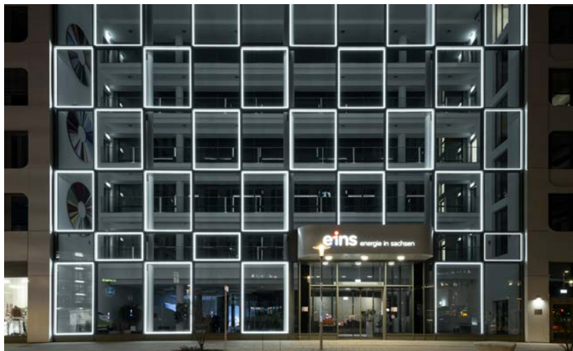
Aus LED, Aluminium, Stahl und Elektronik kreierte der Künstler Hans Peter Kuhn das 22 mal 26 Meter große, nach dem Zufallsprinzip leuchtende Kunstwerk »Lights light« an der Fassade des Verwaltungsgebäudes von eins energie in sachsen in Chemnitz. Foto: Hans Peter Kuhn
