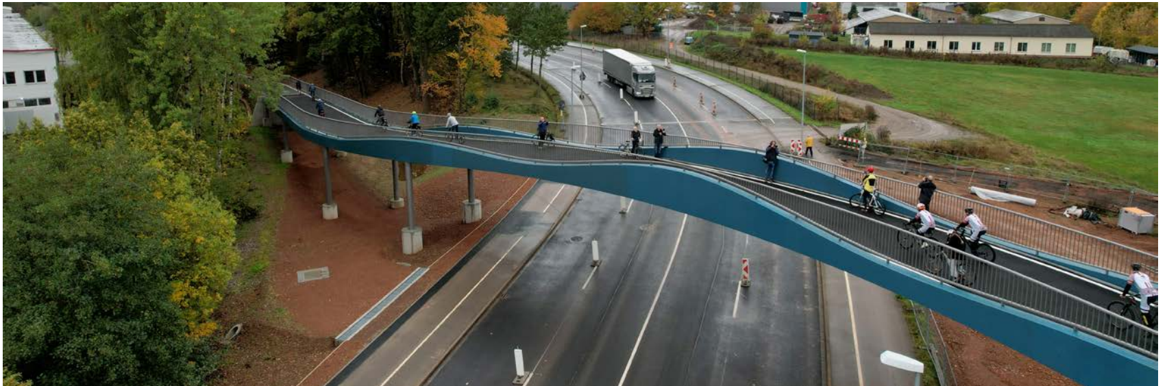
Der Premiumradweg Kuchwald–Wüstenbrand verläuft abschnittsweise auf einer ehemaligen Bahntrasse, ist bis zu vier Meter breit und soll nach Fertigstellung eine Gesamtlänge von rund 13,6 Kilometern erreichen. Bisher wurden die Streckenabschnitte zwischen Riedstraße, Kalkstraße und Paul-Jäkel-Straße fertiggestellt, inklusive einer 185 Meter langen Brücke über die Kalkstraße. Das Projekt schafft eine direkte und attraktive Verbindung für den Radverkehr zwischen den Stadtteilen Rottluff und Rabenstein. Foto: Franziska Wöllner
