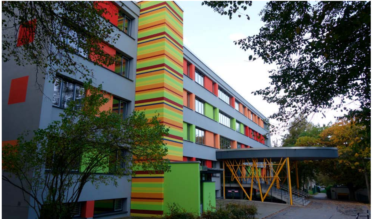
Die Heinrich-Heine-Grundschule verfügt über Sportanlagen, die jetzt saniert werden.
