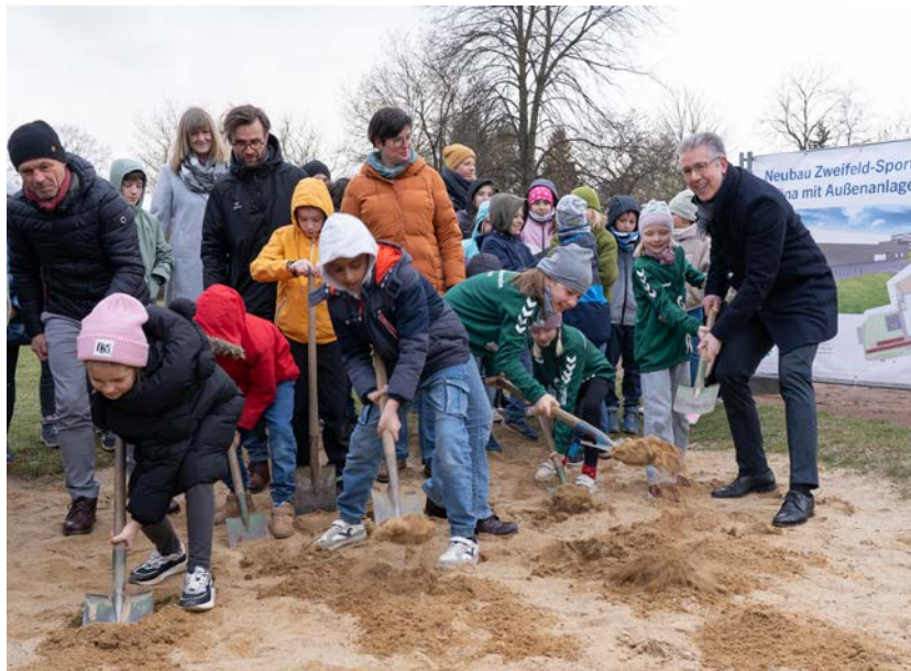
Gemeinsam mit Schülerinnen und Schülern der Baumgarten-Grundschule hat Bürgermeister Ralph Burghart (rechts) den ersten Spatenstich für die neue Zweifeldsporthalle in Grüna gesetzt. Foto: Walter A. Müller-Wähner
