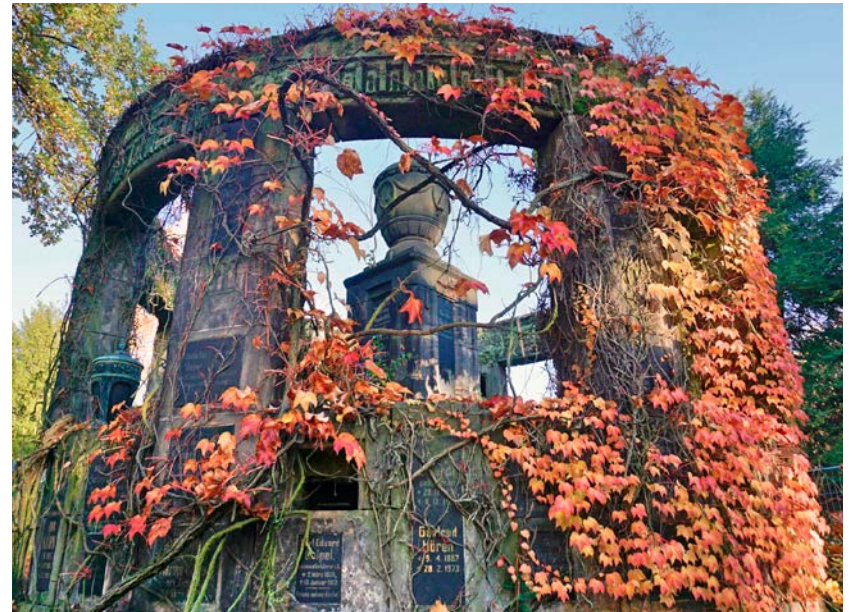
Bei den Sanierungsarbeiten wird unter anderem der Bewuchs entfernt und eine Steinrestaurierung durchgeführt. Foto: Städtischer Friedhof Chemnitz
