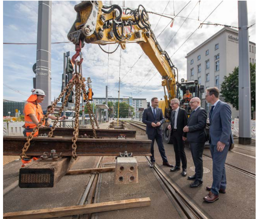
Statt eines ersten Spatenstichs wurde ein altes Stück Geis symbolisch entfernt. Im Bild (von links nach rechts): Landtagspräsident Alexander Dierks, VMS-Geschäftsführer Mathias Korda, OB Sven Schulze, SMIL-Abteilungsleiter Jörg Huntemann. Foto: Walter A. Müller-Wähner
