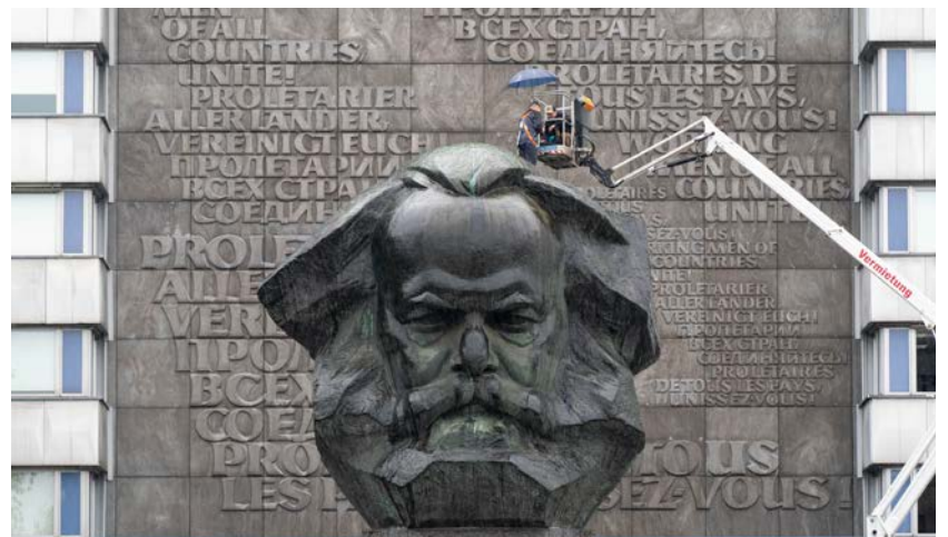
Das Material des Denkmals wird zurzeit getestet. Foto: Franziska Wöllner
