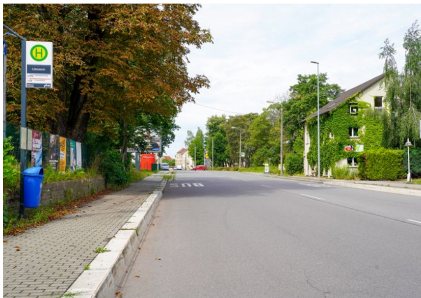
Ein Teil der Zwickauer Straße wird ausgebaut.
