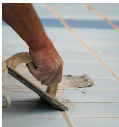
Um die Hallenbäder für die nächste Saison fit zu machen, werden in den Sommerschließzeiten unter anderem die Becken entleert und Fugen gefüllt. Fotos: Madeleine Rödiger
