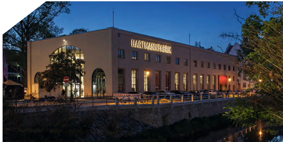
Die Hartmannfabrik: von der Ruine zum repräsentativen Zentrum der Kulturhauptstadt Europas. The Hartmann Factory: from ruin to flagship centre of the European Capital of Culture.
