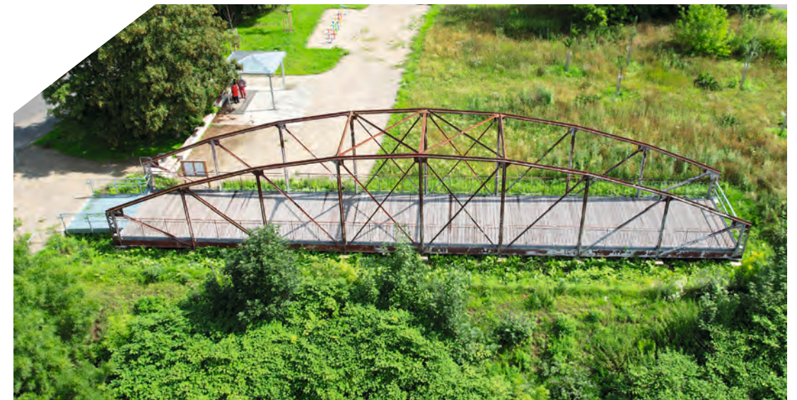
Die Fischwegbrücke ist das zentrale Element des Rastplatzes an der Chemnitztalstraße, Höhe Heinersdorfer Straße. · The Fischweg Bridge forms the central element of the rest area on Chemnitztalstraße, near Heinersdorfer Straße.
