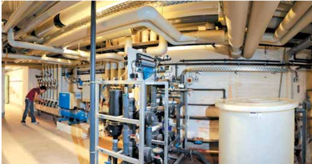
Infolge technischer Veränderungen war der Wasserverbrauch des Stadtbades erheblich gesunken. Jetzt wurden die technischen Systeme daraufhin angepasst und nicht genutzte Leitungen demonitiert. Archivfoto: Ulf Dahl
