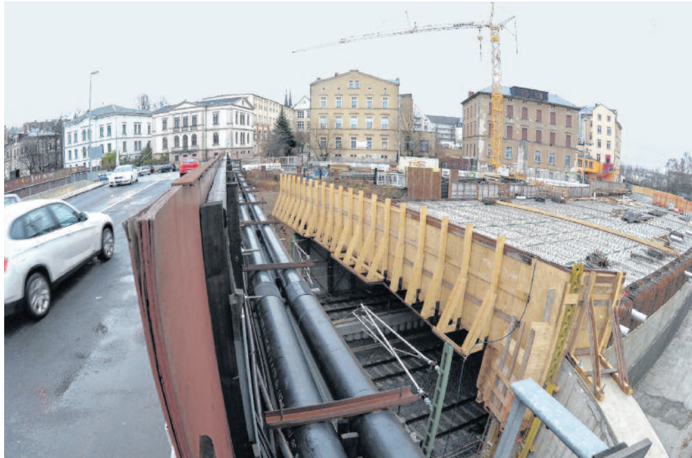
Den Brückenneubau und die Umgestaltung des Dresdner Platzes wird das Tiefbauamt im Dezember abschließen.
