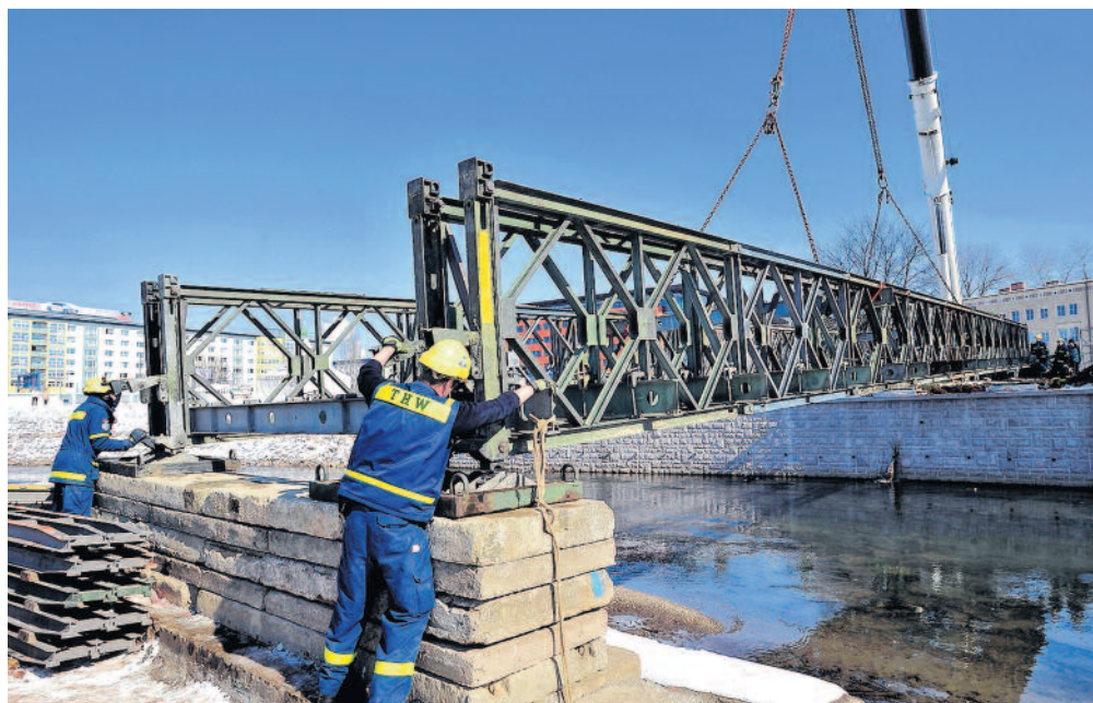
Am Falkeplatz wurde am Wochenende durch das Technische Hilfswerk eine Behelfsbrücke über die Chemnitz gebaut. Damit haben die Vorbereitungen für das Bürgerfest am Samstag begonnen. Foto: Sven Gleisberg
