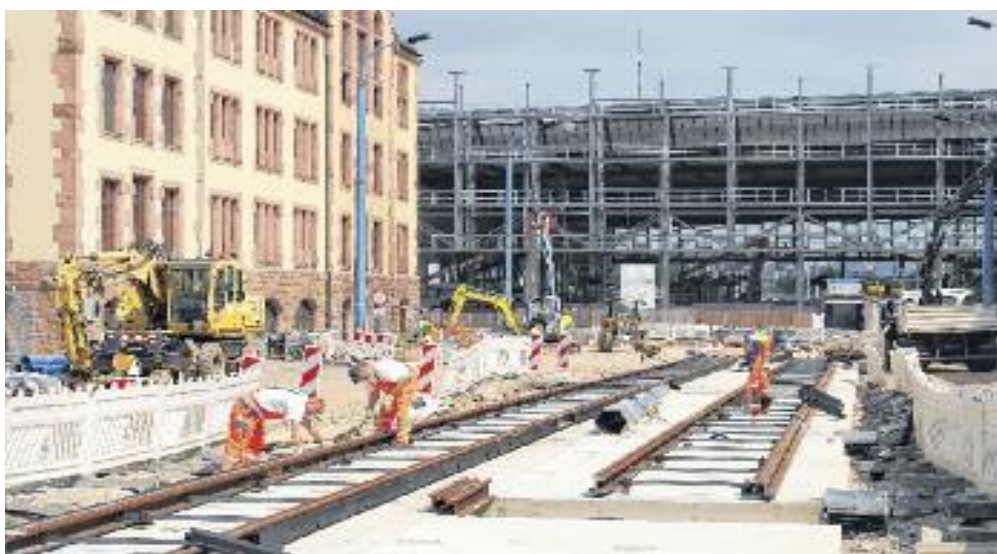
In der zweiten Juliwoche begann das Verlegen der zweispurigen Gleis-Trasse in der Bahnhofstraße. Foto: VMS
