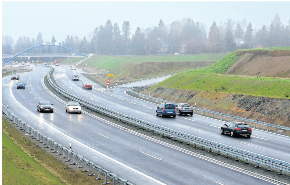
Bundesstraße 174: Nach drei Jahren Bauzeit hat der Freistaat die neue vierspurige Straße für den Verkehr freigegeben. Dafür wurde die bisherige B 174 ab Ortsausgang Chemnitz in Richtung Tschechien auf fünf Kilometern neu verlegt. Foto: Heinz Patzig
