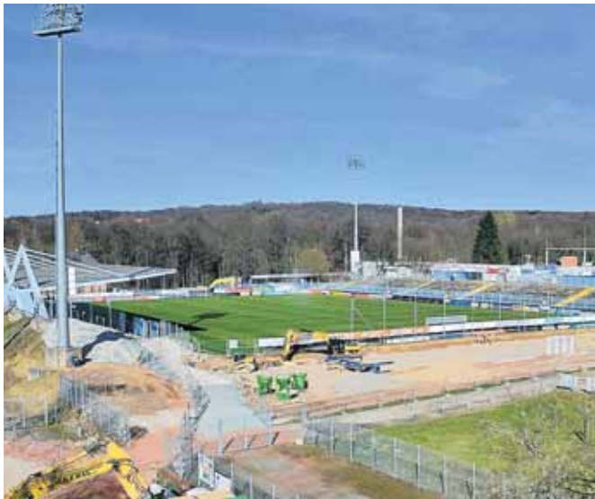
Lang ersehnt von CFC-Anhängern beginnt im Januar endlich der Umbau des Stadions der Himmelblauen. Zunächst muss abgerissen werden, doch schon bald sind erste Tribünen überdacht. Foto: Wolfgang Schmidt
