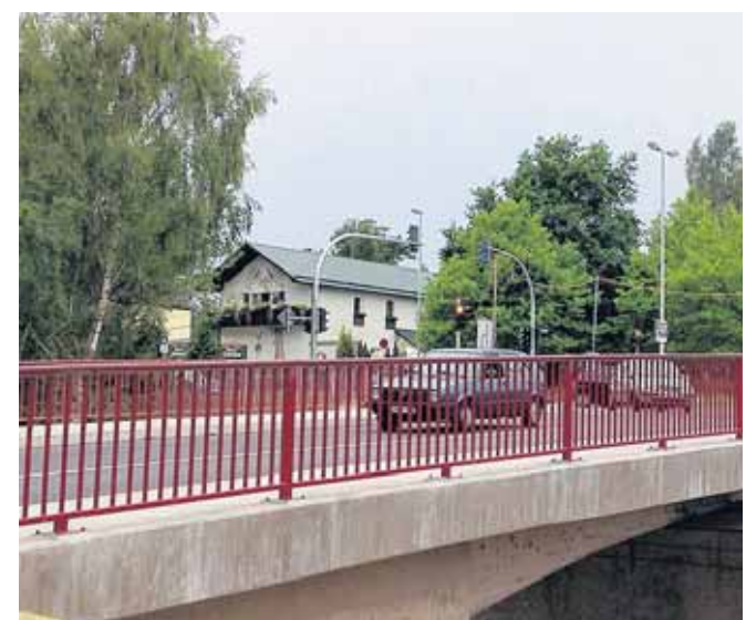
Neu gebaut wurde die Brücke Markersdorfer Straße, die über die Gleise der Linie 4 führt. Das Bauwerk ist seit August befahrbar. Sein maroder Vorgänger musste abgerissen werden. Foto: Thomas Liebert
