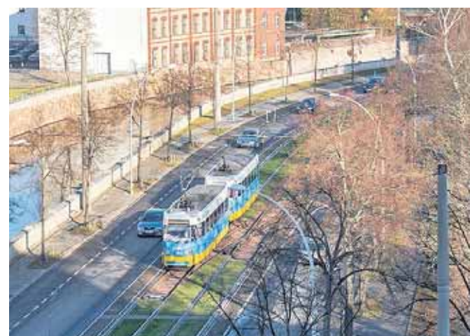
Länger dauernde Gleisbauarbeiten in der Annaberger Straße sind im Herbst beendet worden. Hier modernisierte die CVAG nicht nur die technischen Anlagen auch ein Grünstreifen im Gleisbett entstand. Foto: Kristin Schmidt
