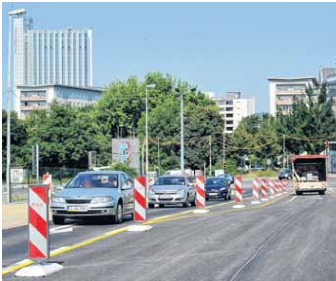
Über vier Jahre läuft das Brückenbauvorhaben am Dresdner Platz. Gemeinsam koordinieren das städtische Baudezernat und die Deutsche Bahn AG das komplexe Projekt. Foto: Christof Heyden
