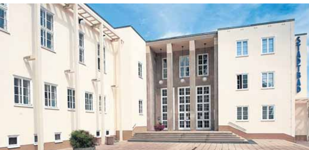
Schritt für Schritt saniert die Stadt eines der wohl schönsten Hallenbäder Deutschlands. Im Stil der Neuen Sachlichkeit erbaut, hat das Hallenbad nach Jahrzehnten der Nutzung nun Erneuerungen nötig. Jetzt wurden u.a. die Lüftungstechnik sowie die Empore der großen Schwimmhalle erneuert. Foto: Ulf Dahl
