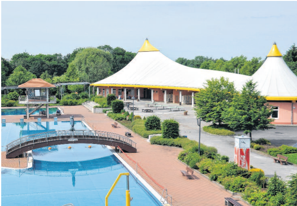
Im Gablenzer Freibad warten die frisch gereinigten und gefüllten Becken ab 30. Mai auf Badegäste.
