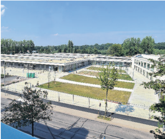
In den Winterferien werden die ersten Schüler den rund 33 Millionen Euro teuren Neubau des Sonderpädagogischen Förderzentrums an der Heinrich-Schütz-Straße – den »Terra Nova Campus« – beziehen und dort hervorragende Lernbedingungen vorfinden.
