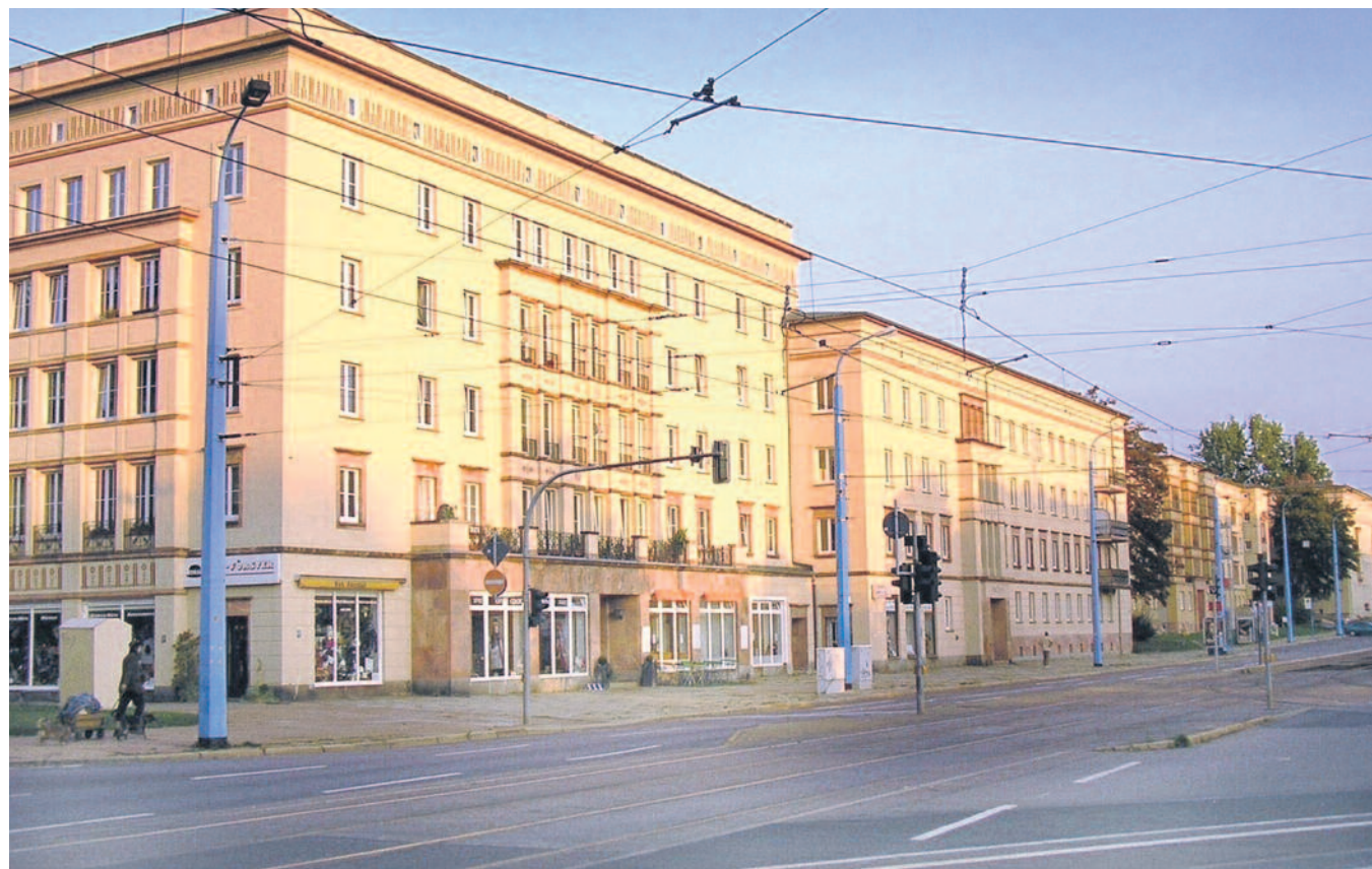
Gemeinsam wollen Chemnitzer Verkehrs-AG (CVAG) und Stadt der Reitbahnstraße von der Annenstraße bis zum Bernsbachplatz und darüber hinaus bis zur Südbahnstraße eine spürbare Schönheitskur verpassen. Foto: Stadt Chemnitz
