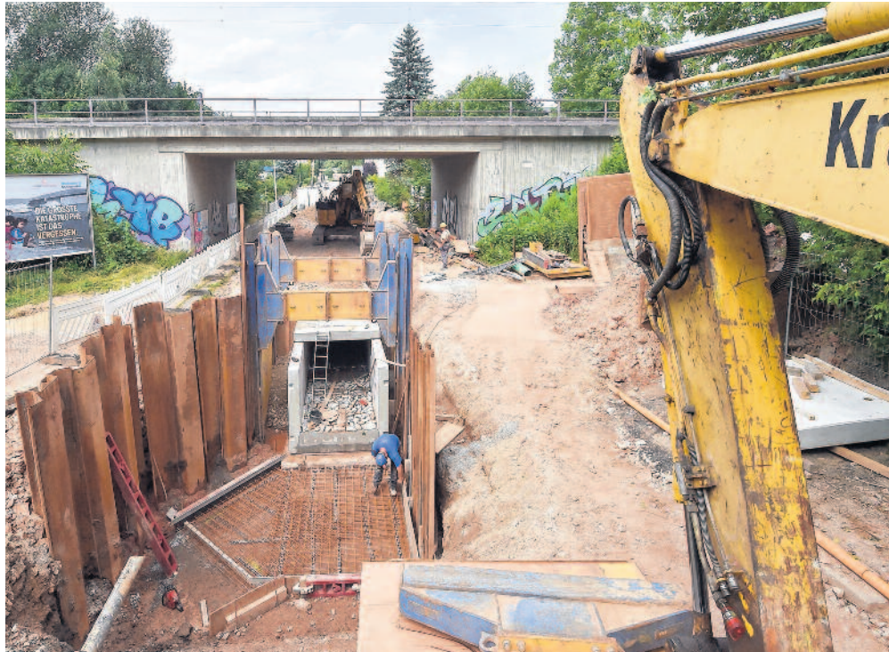
Seit September vergangenen Jahres gibt es in der Stelzendorfer Straße zwischen Zwickauer- und Nauwerckstraße Tiefbauarbeiten. Sie sollen im Oktober 2016 abgeschlossen sein. Foto: Kristin Schmidt
