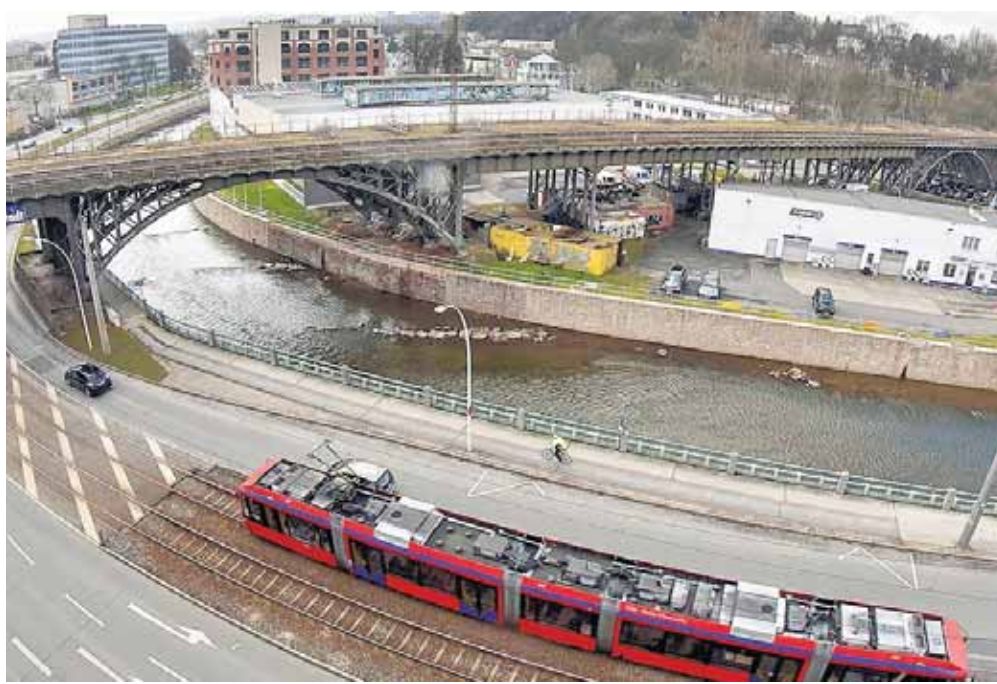
Das Eisenbahnviadukt über Annaberger Straße und Beckerstraße ist ein stadtbildprägendes Verkehrsbauwerk und markantes Zeugnis der frühen Eisenbahngeschichte. In ihrer filigranen Konstruktion wurde sie 1905 erbaut - eine elegant geformte Eisenkonstruktion mit Stahlstützen.
