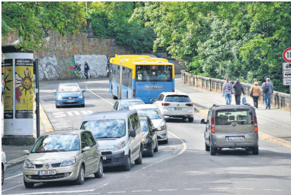
Die Brücke an der Kaßbergauffahrt wurde in Karl-Schmidt-Rottluff-Brücke benannt. Das Bauwerk soll jetzt saniert werden. Foto: Wolfgang Schmidt
