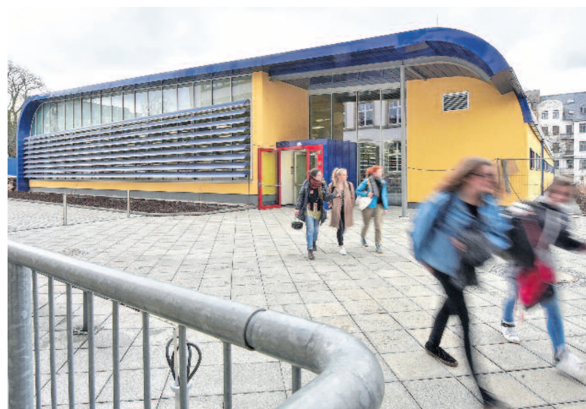
Die neue barrierefreie und behindertengerechte Zweifeld-Sporthalle am Dr.-Wilhelm-André-Gymnasium wurde nach knapp zweijähriger Bauzeit im März übergeben. Die Gesamtkosten betrugen rund 4,26 Millionen Euro, 2,87 Euro übernahm die Stadt Chemnitz. Foto: Kristin Schmidt
