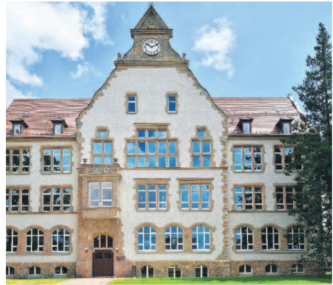
Im Sommer konnten die Rabensteiner an der erneuerten Fassade ihrer Grundschule erkennen, dass deren Sanierung bald abgeschlossen ist. Im Juni wurden im Innern u.a. die Klassenräume hergerichtet. Foto: Wolfgang Schmidt
